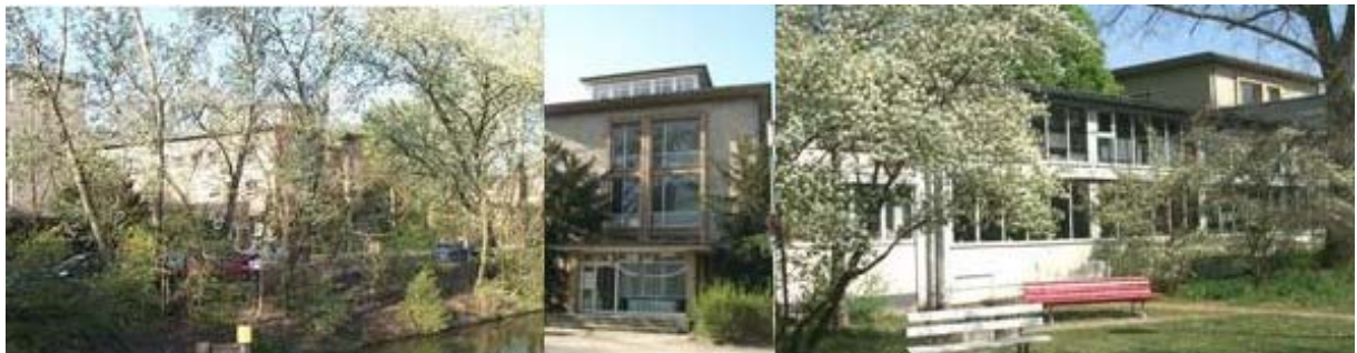
Bild 4: Ansichten des Hermann-Föttinger-Gebäudes
